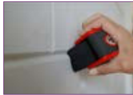
Auf diesem Bild sehen Sie, dass die Hartschaumrolle die Form der gewölbten Oberfläche problemlos annimmt.
