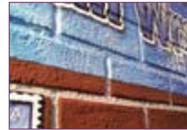
Selbst grobe Ziegelsteine sind kein Problem. Der RollePro schiebt die Folie mühelos in Unebenheiten von Steinen, Ziegeln und Fugen.
