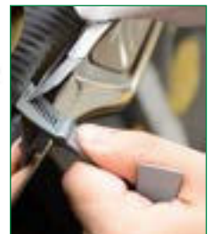
Drücken Sie die Folie in die schwierigen Ecken. Stecken Sie Ihr Messer in den Schlitz und schneiden Sie.
